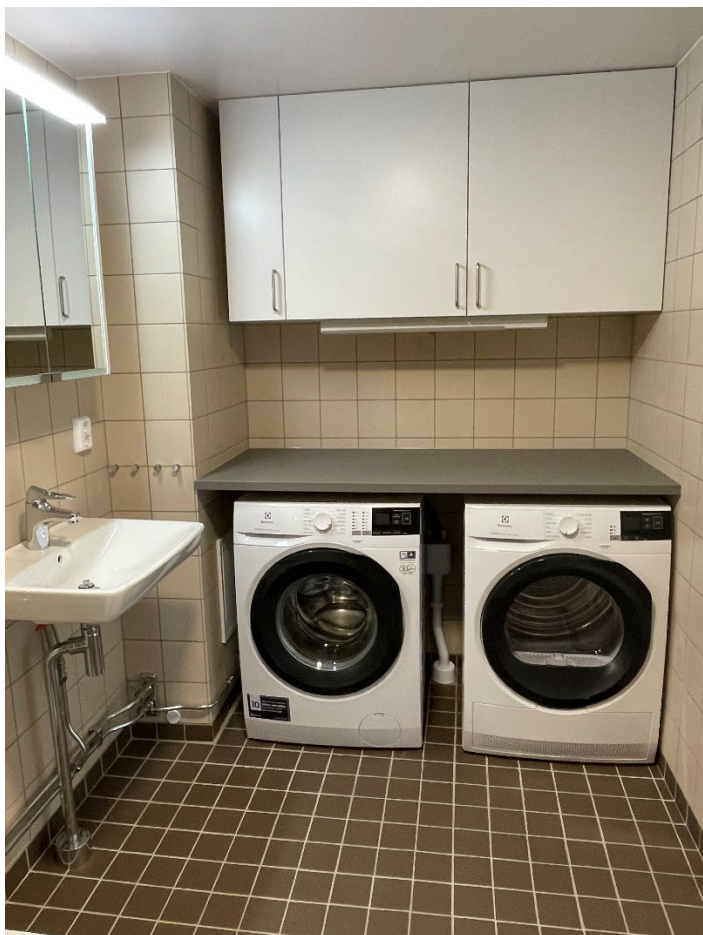
Wc/Duschrum med tvättmaskin och torktumlare
