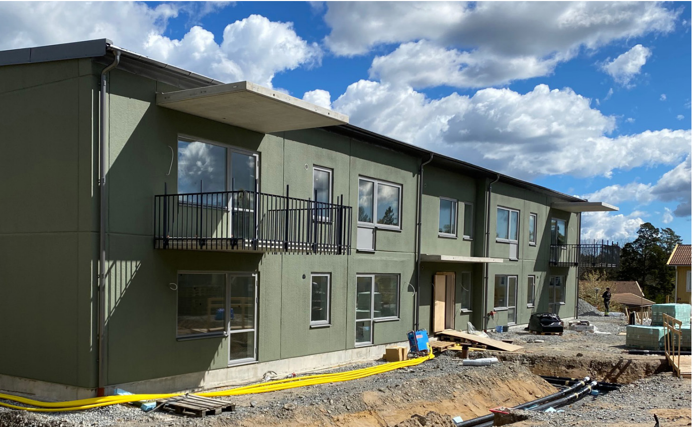
Nyproduktion och inflyttning i kvarteret Jollen på Skansvägen i Vendelsö. 32 lägenheter i två stycken tvåvåningshus. Husen har en stark miljöprofil med bland annat solcellsanläggningar på taken och möjlighet att ladda elbilar.
